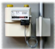
Compteur gaz communicant
