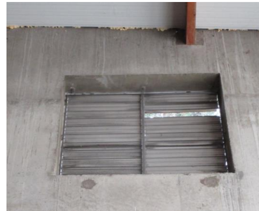
Ouverture directe sur extérieur – Hall des Sports
