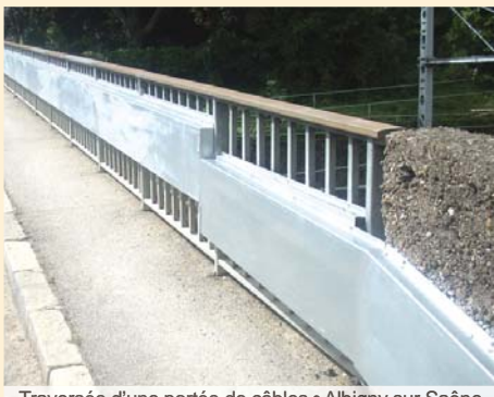
Traversée d'une portée de câbles • Albigny sur Saône
