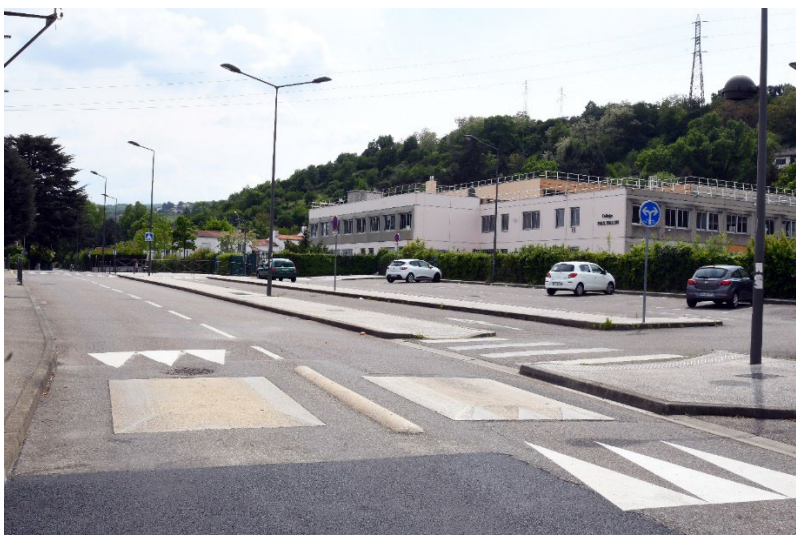
Le quartier des Bans où les nouveaux lampadaires sont installés. © Jacques Del Pino
