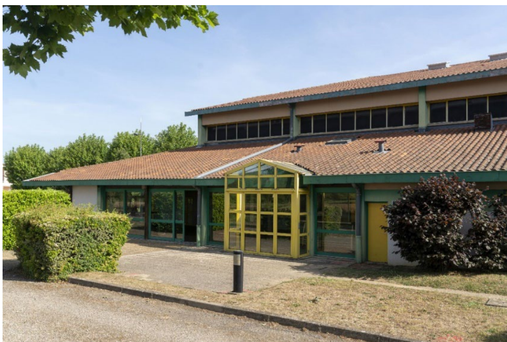
La salle polyvalente avant travaux. © Michel Djaoui
