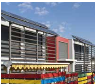
L'installation photovoltaïque du centre de loisirs de Craponne est gérée par le Sigerly.
